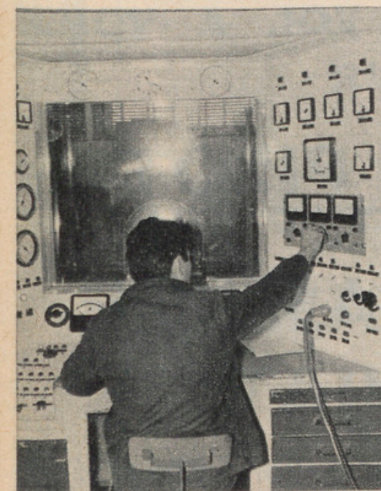
La turbine en cours de contrôle. Cet atelier est alimenté en air purifié... et se trouve en légère surcompression.
