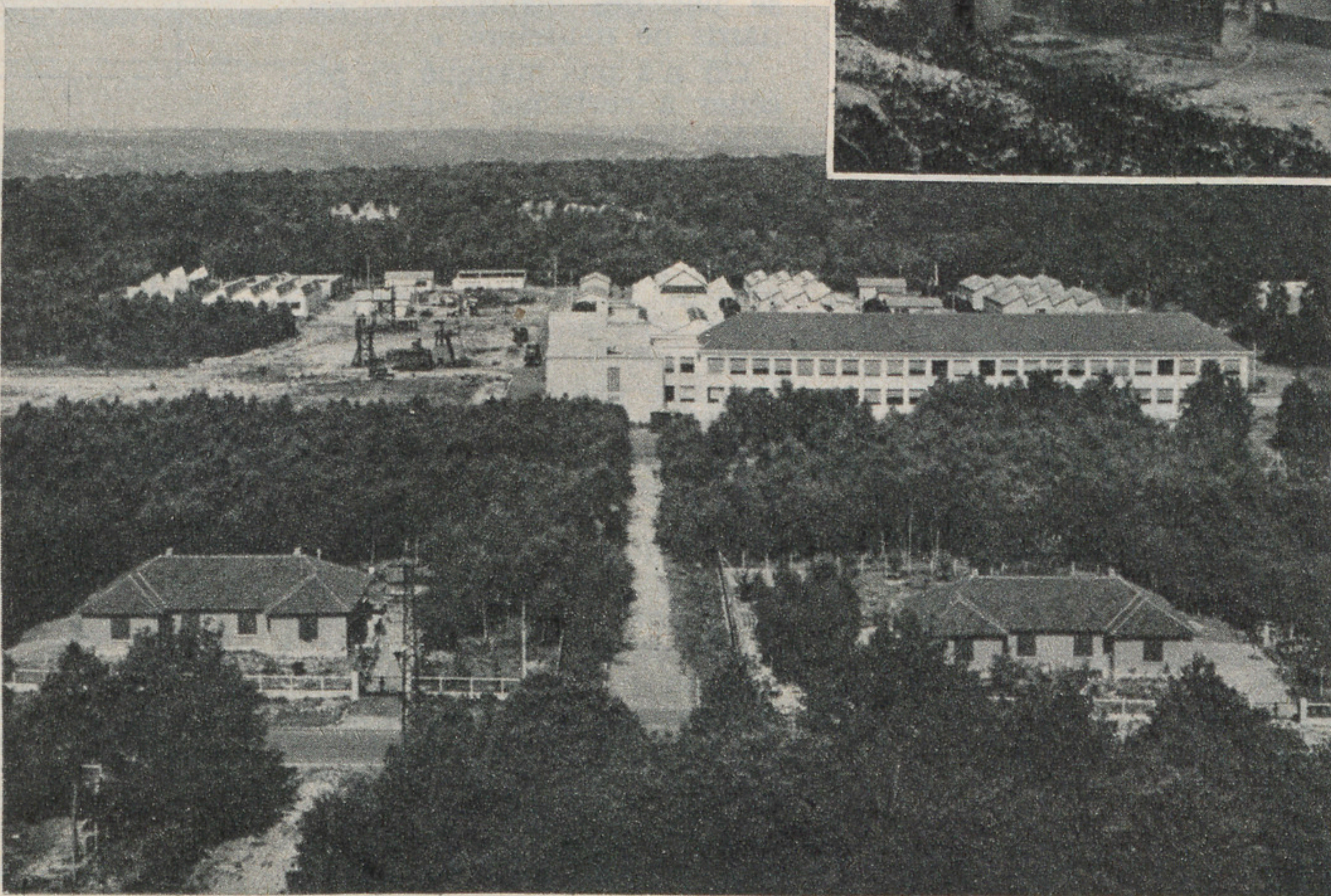
La charpente du nouveau banc d'essais de Vernon pèse 400 tonnes. Elle est appelée à résister aux vibrations produites pendant 90 secondes par des engins développant jusqu'à 100 tonnes de poussée. On distingue en haut de la tour les réservoirs alimentant les moteurs à l'essai et, à ses pieds, le carnaud vers lequel sont dirigées les flammes. Ci-contre, une vue générale des installations de Vernon. C'est dans les bois, au second plan, que la tour a été implantée...
