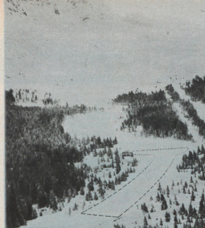
L'altiport de Méribel (Savoie) et sa piste en terre compactée de 400 m sous 10 % de pente. Ses installations fixes comportent un hangar, un bar-restaurant, une route d'accès. Commencé en 1961, il fut terminé en 1964 par la commune elle-même.
